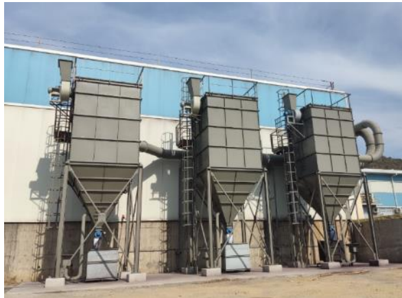
Слика 22 Надворешни единици (филтри) на систем за вентилација и аспирација
