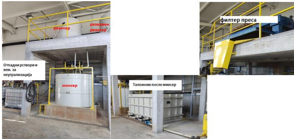
Слика 53 Систем за неутрализација на отпадни води од бакарисување
