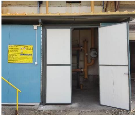
Слика 30 Редукциска станица за природен гас
