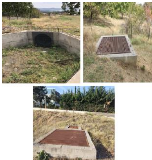
Слика 24 Собирни шахти и таложници за атмосферските води
