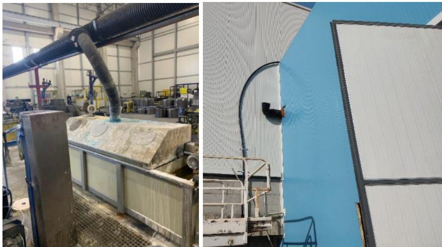
Слика 65 Систем за аспирација на киселински пари и испуст во атмосфера
