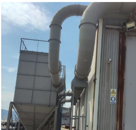
Слика 18 Цевки за довод на отпадни гасови до надворешни филтерски единици
