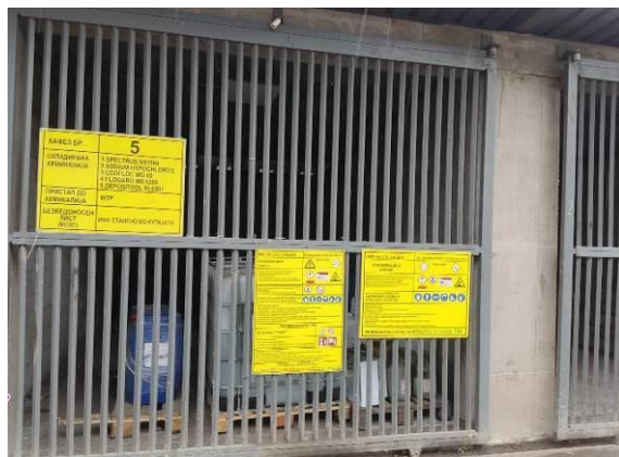
Слика 15 Магазин за складирање на хемикалии за одржување на рецикулаторниот систем на „Водостопанство“
