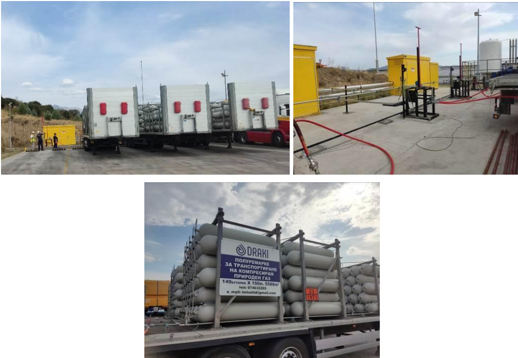
Слика 29 Станица за природен гас и декомпресорска станица
