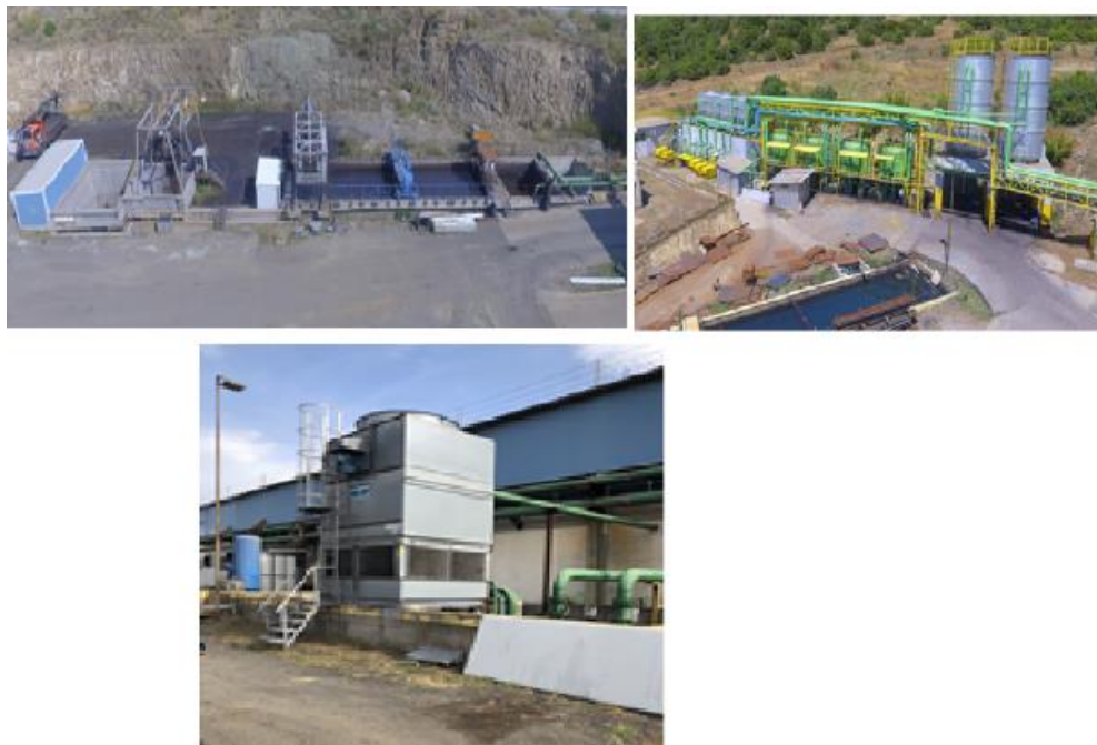
Слика 25 Систем за третман на технолошките отпадни води
