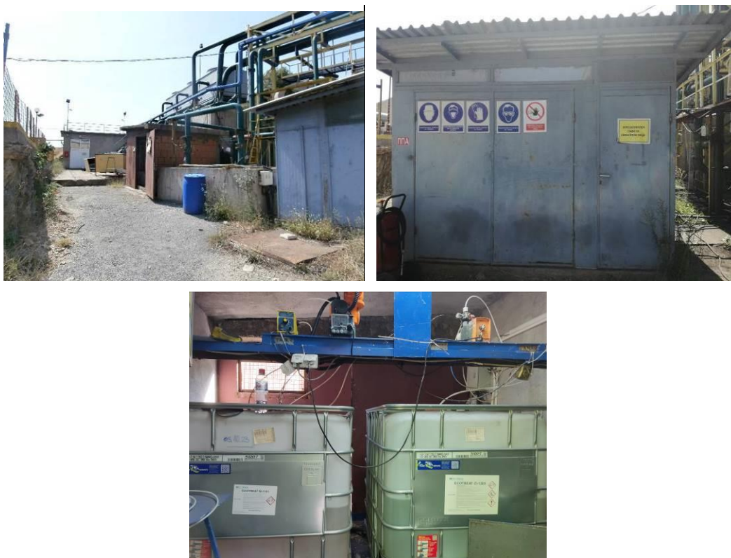
Слика 16 Објекти за дозирање на хемикалии во Водостопанство и систем за дозирање
