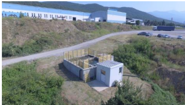
Слика 23 Пречистителна станица за третман на санитарни отпадни води
