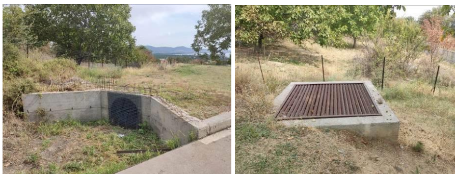
Слика 49 Собирни канали и таложник за атмосферски води
