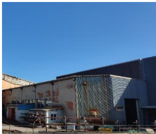
Слика 19 Машинска работилница
