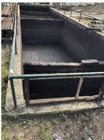
Слика 26 Стар таложник кај Водостопанство
