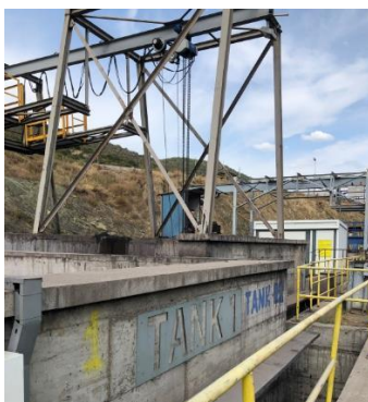
Слика 1 Базен за грубо таложење
