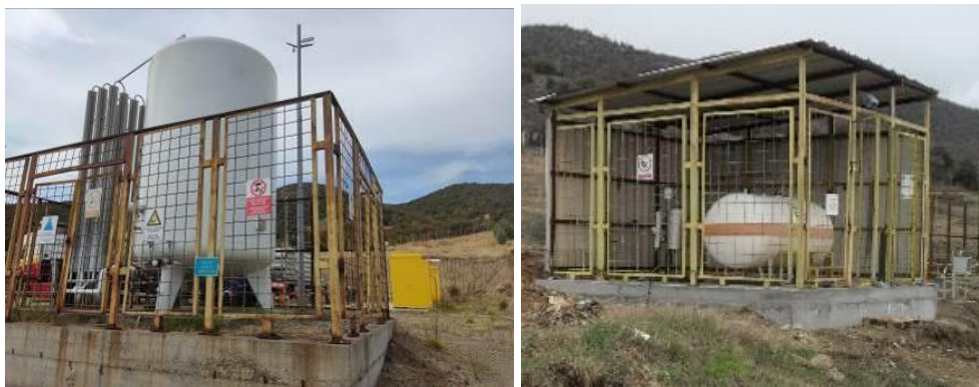
Слика 18 Станици за пропан бутан и кислород
