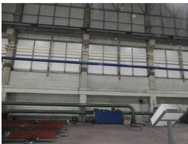
Слика 19 Цевки за снабдување со пропан-бутан (жолта цевка), кислород (бела цевка) и компримиран воздух (плава цевка)
